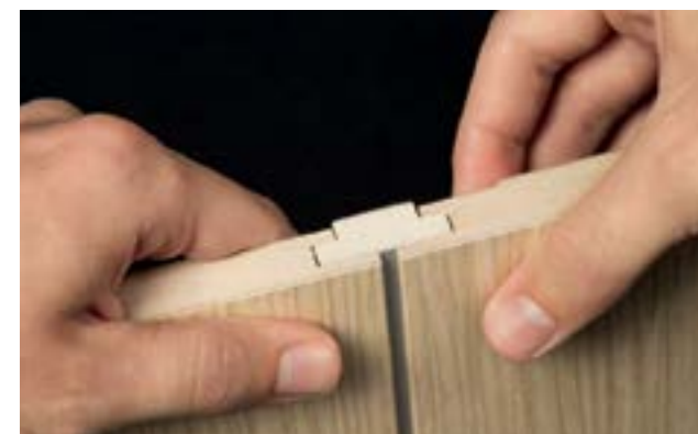
Panel drážka-drážka s vloženým perem, stínová spára
